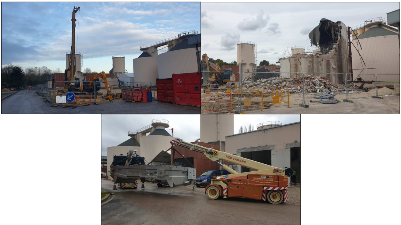
Figure 1 : Travaux pour l'amélioration de la filière boue à la station de Barberey
