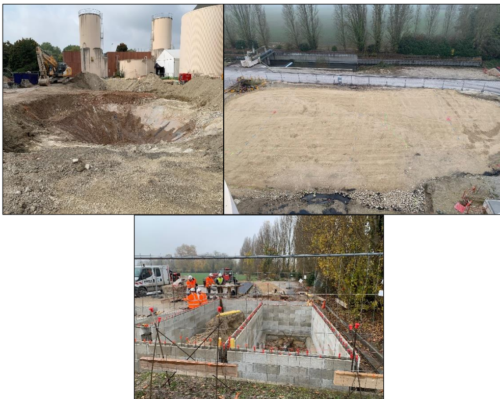
Figure 1 : Travaux pour l'amélioration de la filière boue à la station de Barberey
