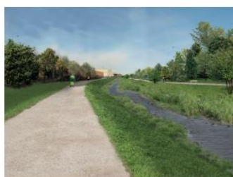
Digue de Bolloré
