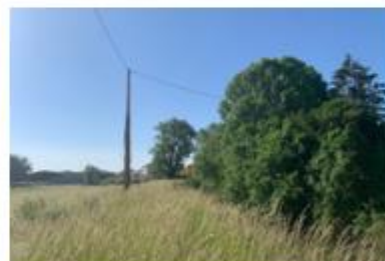
Digue Bas Trévois
