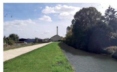
Digue Bas Trévois
