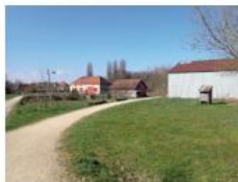
Digue du Parc des Moulins
