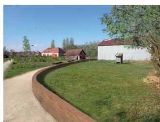
Digue du Parc des Moulins
