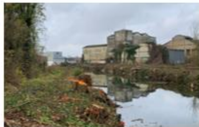
Digue de Bolloré
