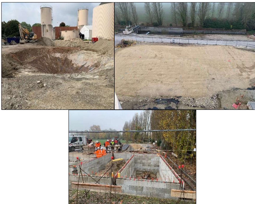
Figure 1 : Travaux pour l'amélioration de la filière boue à la station de Barbère
