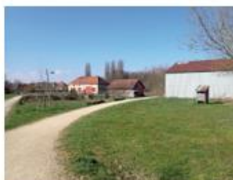
Digue du Parc des Moulins
