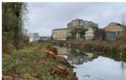
Digue de Bolloré
