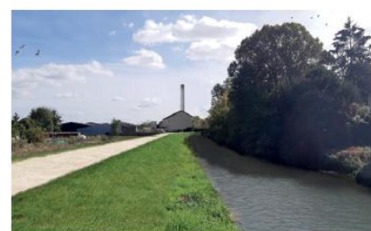
Digue Bas Trévois
