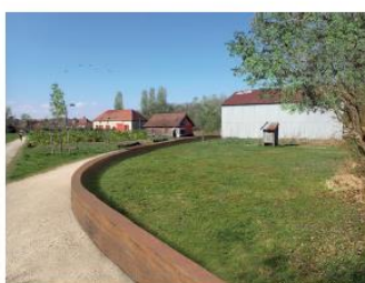
Digue du Parc des Moulins
