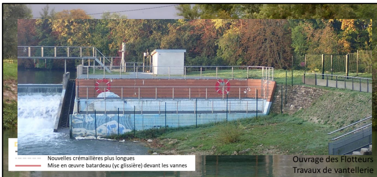
Figure 7 - consistance des travaux – ouvrage des Flotteurs
