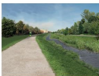
Digue de Bolloré
