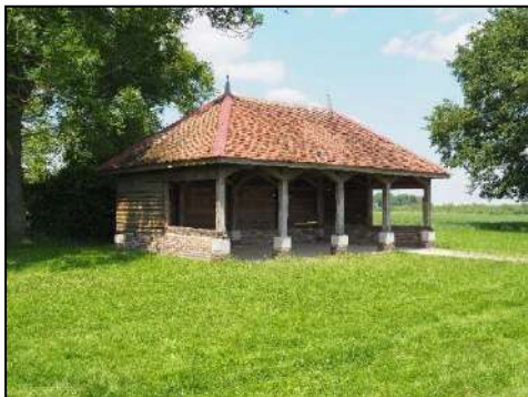
Lavoir terrain de sport, rue du Vazon
