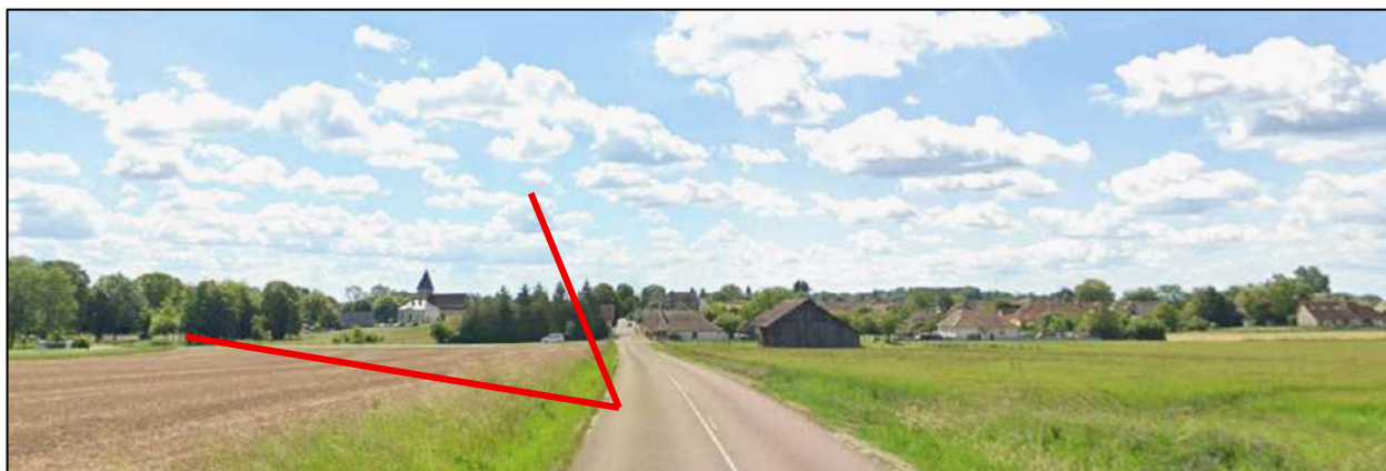
Cône de vue depuis la RD85, entrée Nord de Moussey
