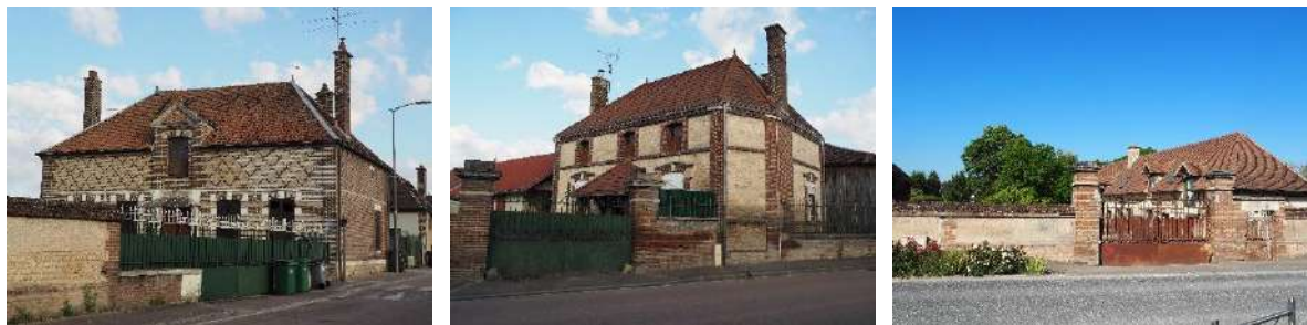
Construction ancienne en briques (en chaînage ou en façade), pierres calcaires ou pans de bois
