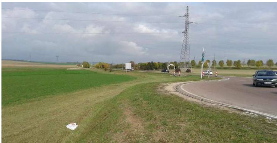
La RD677 reliée au rond-point (Source : SCE, octobre 2016)
