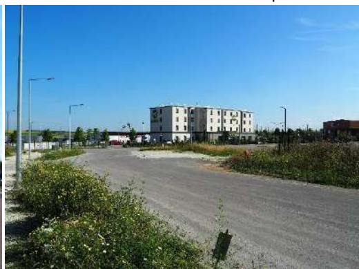
Partie en construction du pôle d'activités
