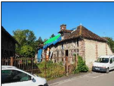
Grande Rue - Lavau
