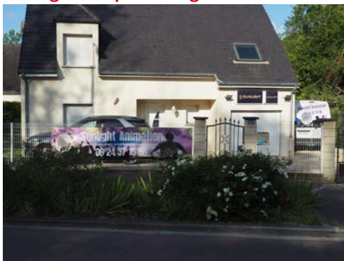
Enseignes sur la façade et sur clôture
