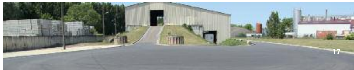
L'aire de retournement du poste de transfert des Ecrevolles
