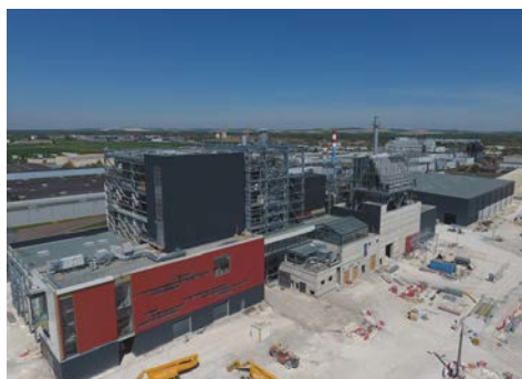
Vue du chantier (pose revêtement extérieur)
