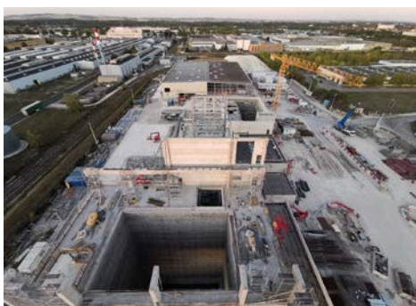
Vue du chantier (montage de la fosse)
