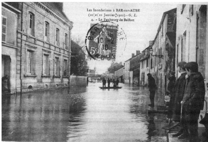
Bar-sur-Aube : Crue de 1910
