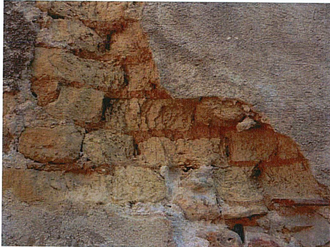
Les murs en briques de terre
