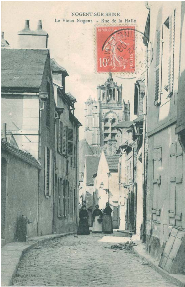
Vue sur l’église depuis la rue de la Halle
