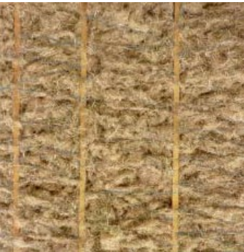
Laine de chanvre en vrac mise en œuvre dans une ossature bois
