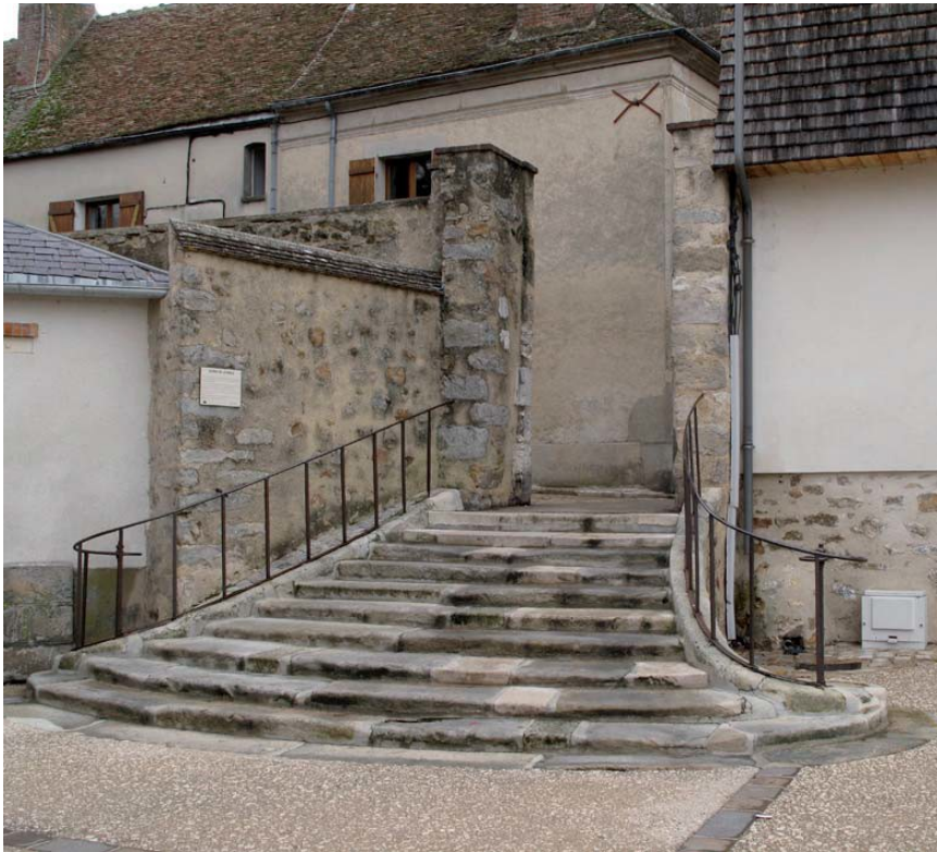
Escalier rue de la Halle
