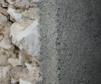
Copeaux de chanvre en vrac, mise en œuvre sèche sur plancher et béton de chanvre en mise en œuvre sur maçonnerie
