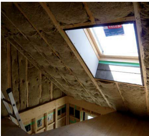
Rouleaux de laine de chanvre et de lin et mise en œuvre en sous-face de toiture
