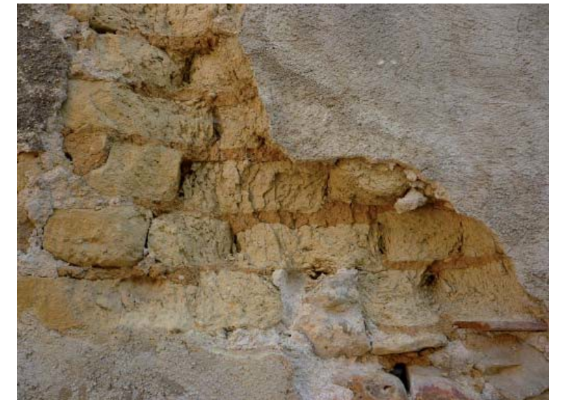
Les murs en briques de terre
