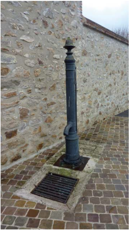
Pompe à eau rue de la Bonde
