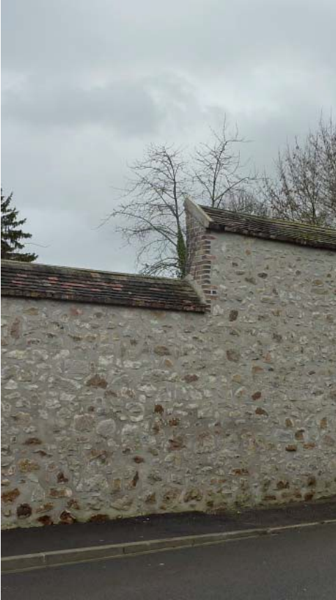
mur en moellon
