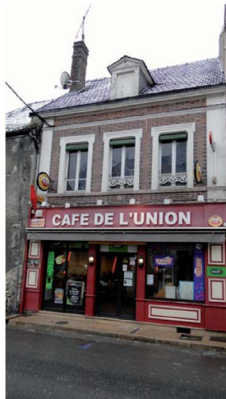
Maison de la 2 e moitié du 19 e siècle, dont la façade est dénaturée par une devanture et une enseigne ne tenant pas compte de l'élévation du 1 er étage.
