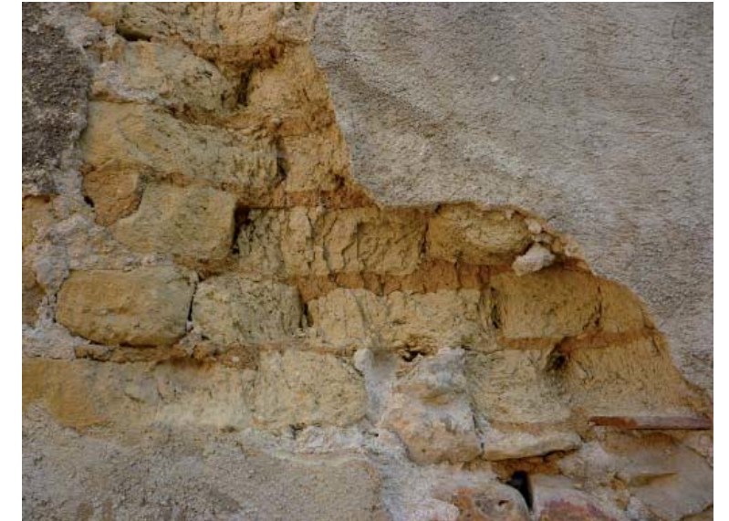
Les murs en briques de terre
