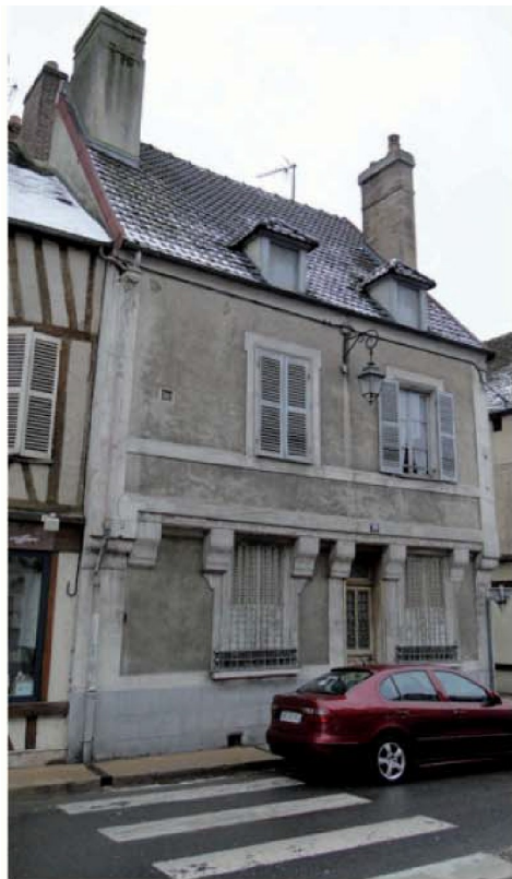
Maison du 16 e siècle, en pan de bois et premier étage en encorbellement, dénaturée dans le premier tiers du 20 e siècle par le percement des fenêtres trop larges au rez-de-chaussée. Les gardes-corps en ferronnerie et les persiennes métalliques, qui seraient à conserver pour d'autres types d'architecture, sont en ce cas inadaptés.
