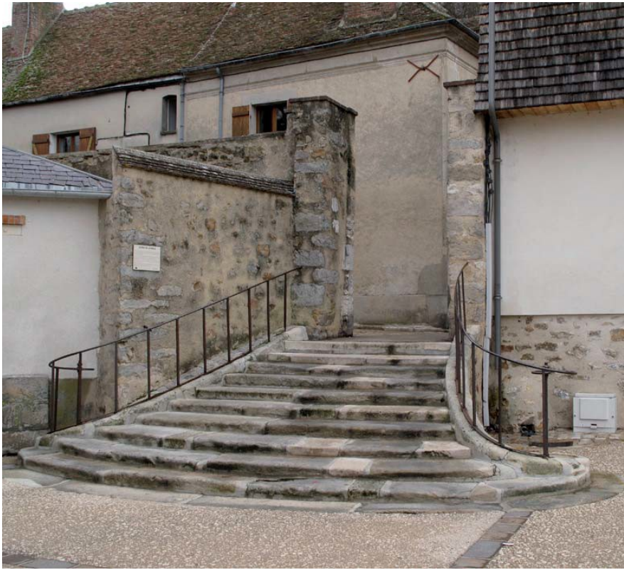
Escalier rue de la Halle
