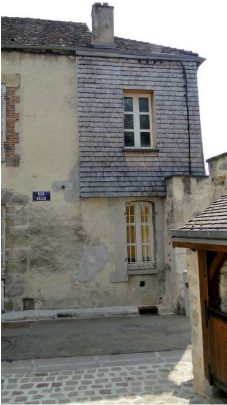
Bardeaux de châtaignier en bardage vertical
