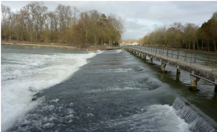
Déversoir sur la Seine et passerelle reliant l'île Olive
