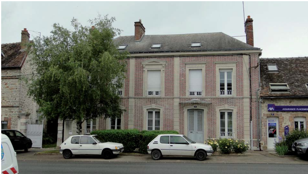
La brique à l'intérieur d'un réseau de chaînes en pierre
