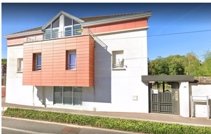
Photo 5. Pôle multi-accueil La Ribambelle – Source : google maps
