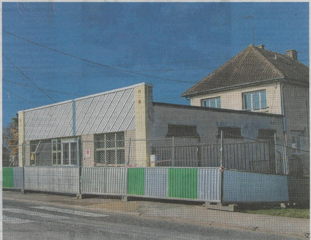
Les travaux avancent à la Maison pour tous, un projet dédié à la cohésion sociale.
