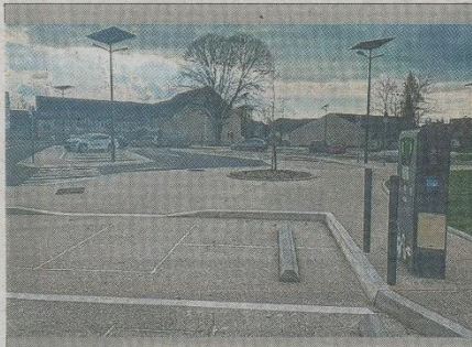
Un parking flambant neuf pour la salle de sports de combat, mais aussi devant les immeubles de la rue du 8-Mai, pour plus de confort.
