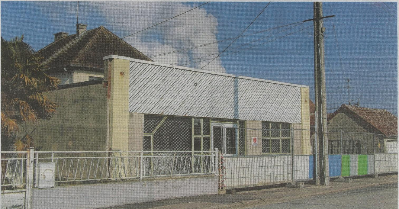
Encore en chantier, la Maison pour tous ouvrira ses portes bientôt. Photo d'archives
