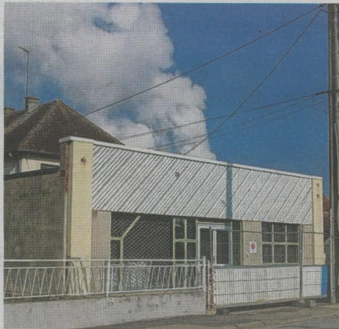
Les travaux avancent à la Maison pour tous, un projet dédié à la cohésion sociale. Archives
