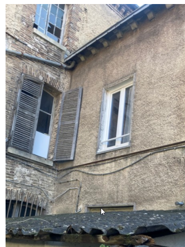
Jonction entre la bâtiment principal et l'aile gauche
