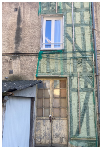
Porte d'accès du lot 55
