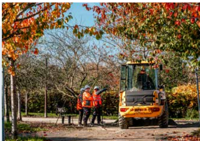
Les travaux de réfection de la voie verte des Viennes
