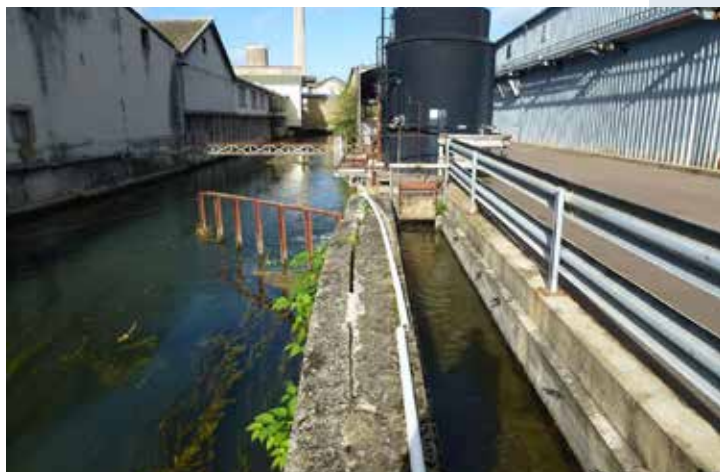
La digue des Bas-Trévois
