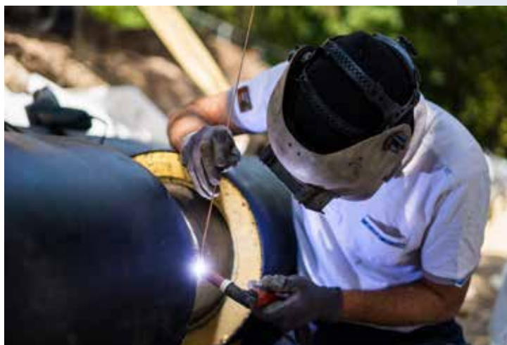
Travaux de raccordement à l'UVE
