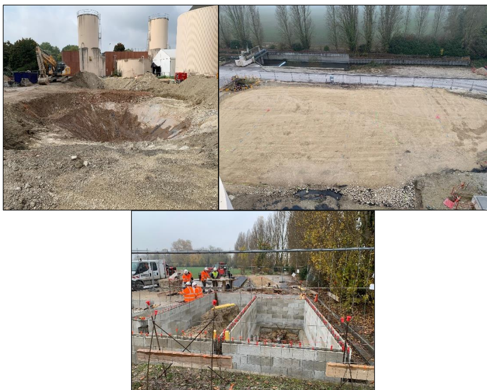
Figure 1 : Travaux pour l'amélioration de la filière boue à la station de Barberey
