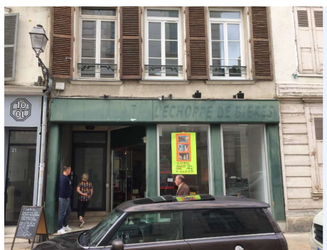
Façade avant travaux
