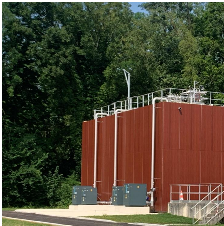
Figure 1 : Travaux pour l'amélioration de la filière boue à la station de Barberey Bâtiment de traitement des centrats
